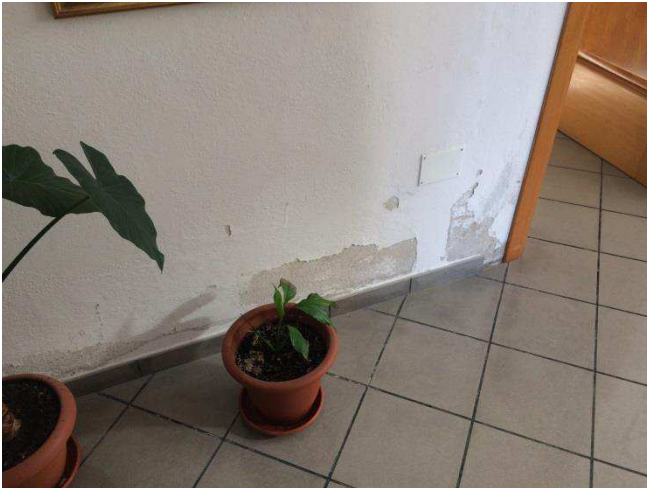
Intonaci interni – Fenomeni di esfoliazione dovuti all'umidità
