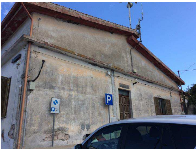
Intonaci esterni – Fenomeni di esfoliazione, patina biologica, distacco, perdita cromatica
