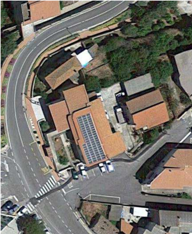
Foto aerea dell'edificio
