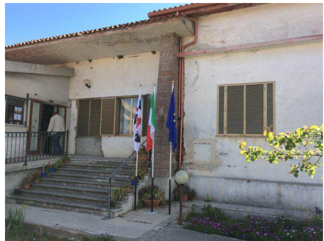
Intonaci esterni – Fenomeni di esfoliazione, patina biologica, distacco, perdita cromatica
